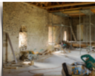
Travaux sur les fenêtres Nord.
