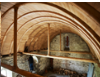
Montage de la charpente.
