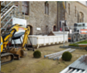
Décaissement du sol.
