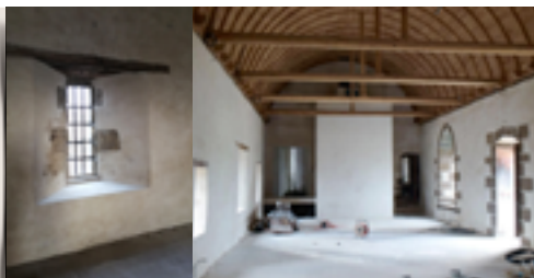
Enduits Salle haute et en rez-de-chaussée.
