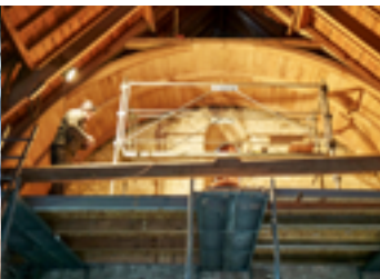
Pose de quelques travées de charpente.
