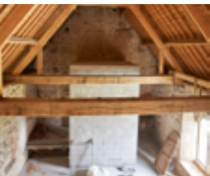
Montage cage d'ascenseur.
