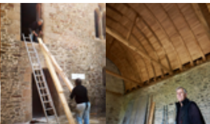
Travail des charpentiers.
