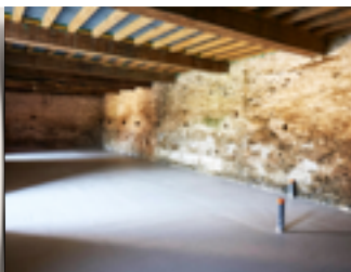
Dalle du RdC coulée.
