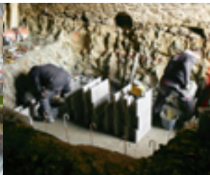
Coulage cuve d'ascenseur.
