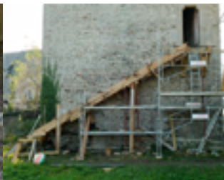
Montage escalier de secours.
