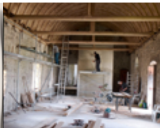
Enduits à la chaux.
